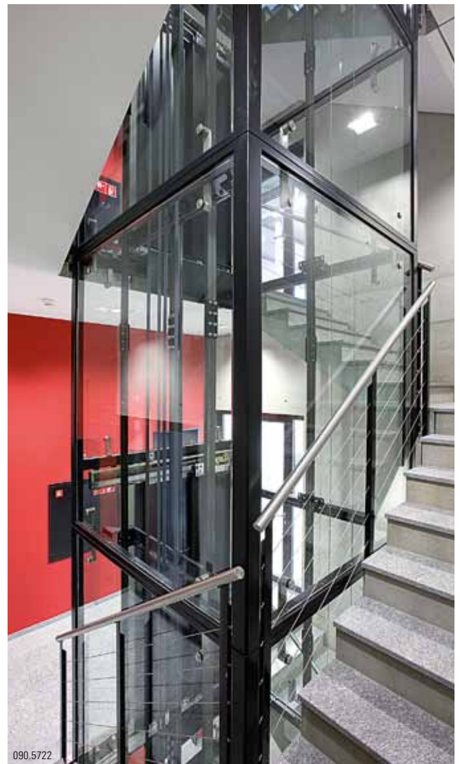
Podest im Treppenhaus des ersten Obergeschosses Süd, mit Lift in Glasfassade.
