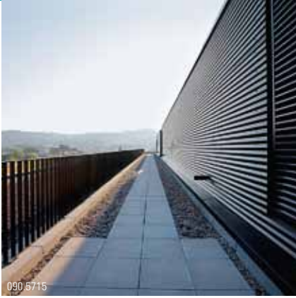
090.5715 Aussichtsweg «hin und zurück» auf dem Kubusdach, nebenan Fassade zur Abdeckung der Gebäudetechnik.
