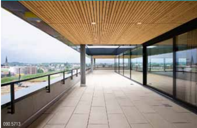
Terrasse im fünften Obergeschoss mit Holzakustikdecke.
