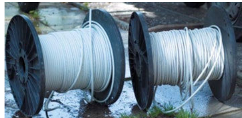
Câble en cuivre stocké dans de mauvaises conditions
