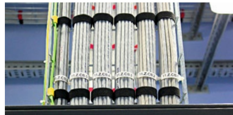
Fixation correcte des câbles verticaux
