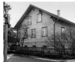
Die Wohnhäuser der Familie Reichle in Wetzikon und der Familie De-Massari in Pfaffhausen wurden als Büros, Produktionsstätte und Lager benutzt.
